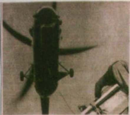
Das 600 kg schwere Zelt aus doppelt beschichtetem Dederon hat sein Ziel auf dem 18 Meter hohen Holzgerüst 21 Meter über der Erde erreicht. Die Last wird abgehängt, die Hubschrauber-Besatzung bekommt das Zeilchen: „Danke!“
