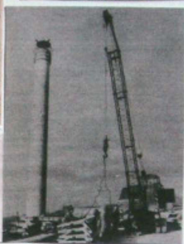
Das 600 kg schwere Zelt aus doppelt beschichtetem Dederon hat sein Ziel auf dem 18 Meter hohen Holzgerüst 21 Meter über der Erde erreicht. Die Last wird abgehängt, die Hubschrauber-Besatzung bekommt das Zeilchen: „Danke!“
