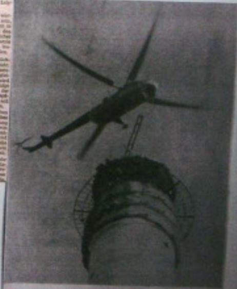
Der Hubschrauber DM-SPE vom Helikopter-Spezialflug hebt einen der 600 Kilo schweren Träger ab, auf dem die Dederonzelle mit 18 Meter Durchmesser des Bauzweitesystems gegen die Witterung blown wird.
